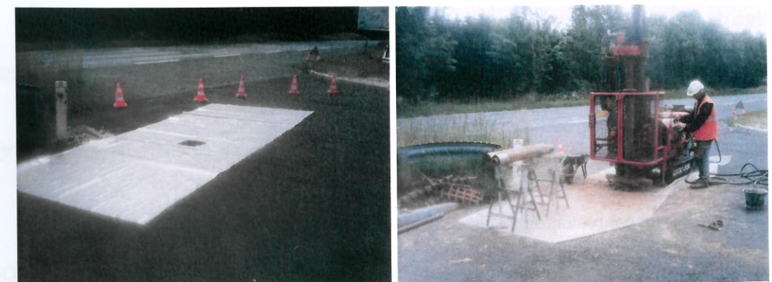
Figure n°8 : Réalisation du piézomètre PZD
